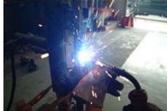
【写真-1 横向き溶接の施工状況】
