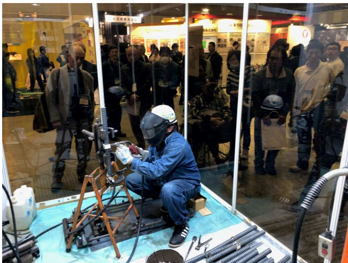
写真－2 柱方向溶接
