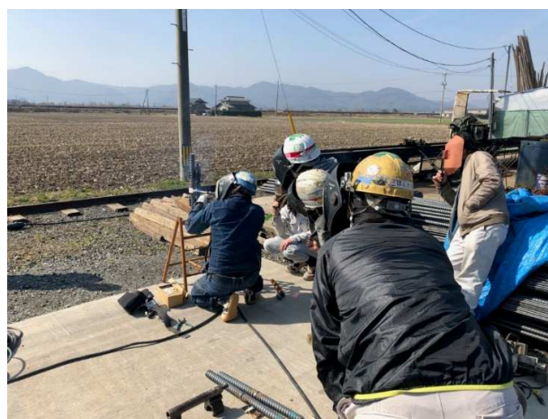
写真二 参加者が横向き溶接を行っています。 SD490 D41ネジ鉄筋を溶接
