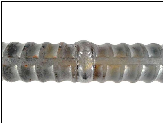
写真-1. 2 下向き溶接横側
