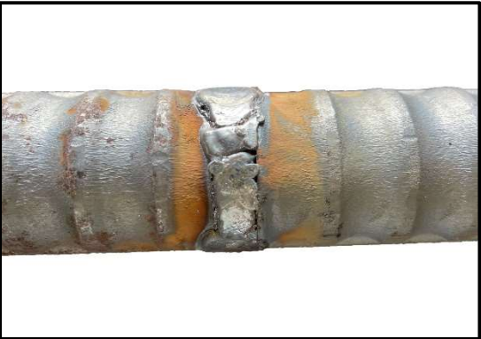
写真-3. 3 溶け込み不足
