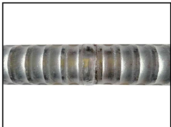
写真-2. 3 横向き溶接裏側
