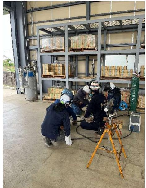
写真-2 SD390 D41 タケ節鉄筋溶接
