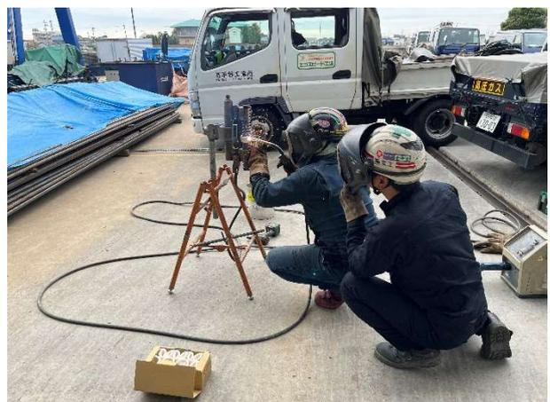
写真-4 SD390 D32 タケ節鉄筋溶接
