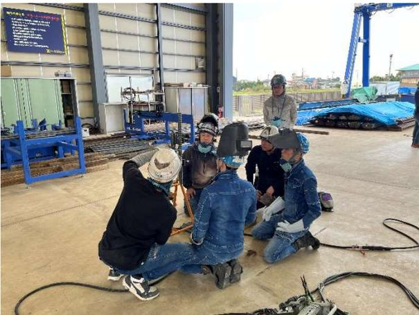
写真-1 SD490 D41 ネジ節鉄筋溶接
