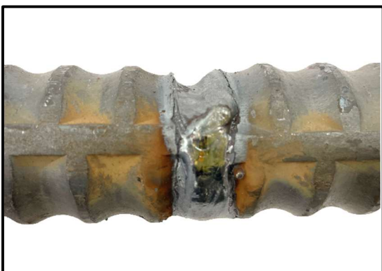
写真-3. 4 余盛高さが鉄筋径より低い
