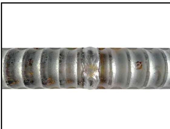
写真-1. 3 下向き溶接裏側
