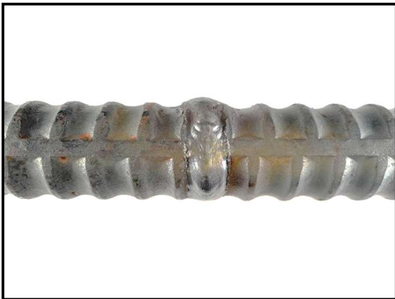
写真-1. 2 下向き溶接横側
