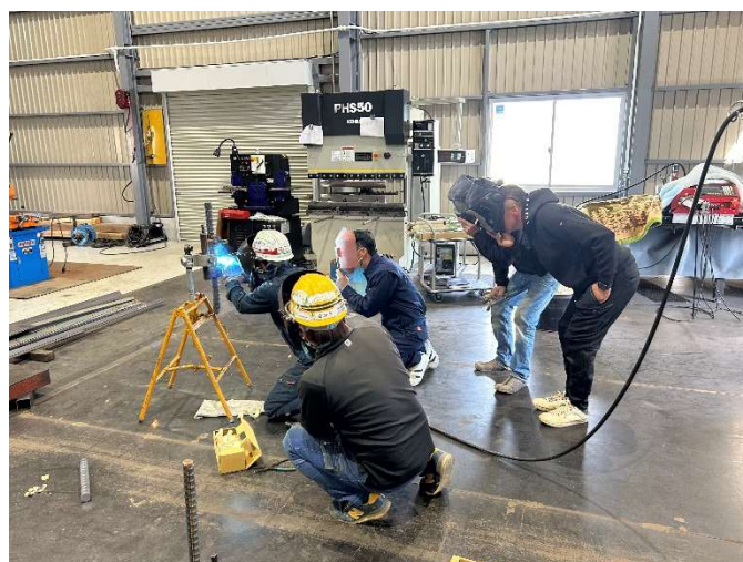
写真-4 SD390 D41 タケ節 柱向き溶接
