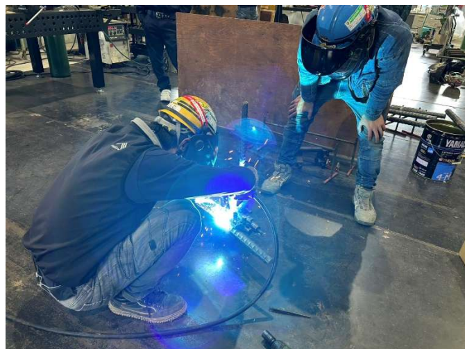
写真-2 SD390 D41 タケ節 梁向き溶接
