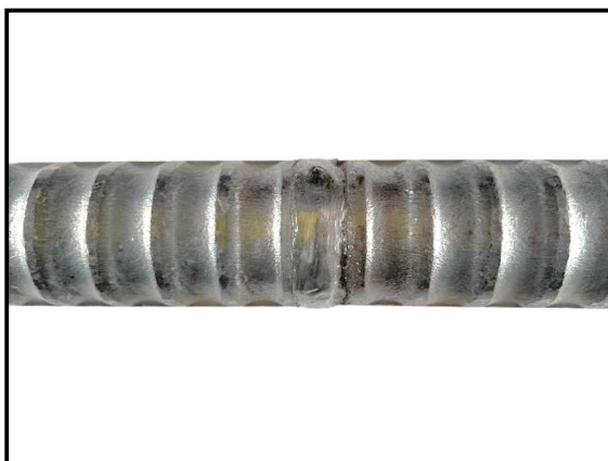
写真－2. 3 横向き溶接裏側
