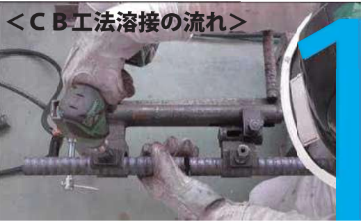
鉄筋支持器で鉄筋を固定
